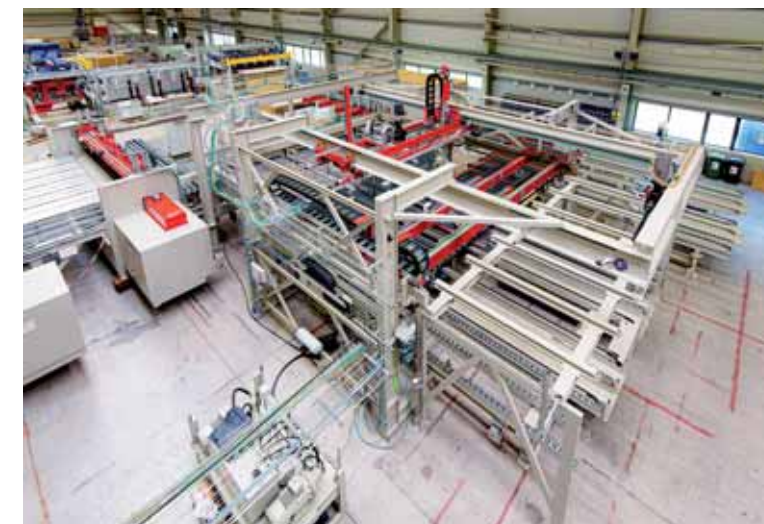
Blick auf die Beschickung mit einer Kombination aus verschiedenen Zuführungsmöglichkeiten: Die Vakuumbeschickung übernimmt die Zuführung der Materialien mit sehr empfindlicher Oberfläche. Einzelplatten werden angesaugt und in der Paketbildstation zu einem Sägenpaket gebildet. Die Dünnplattenbeschickung (Detailbild links oben) rundet das vielfältige Zuführsystem ab
